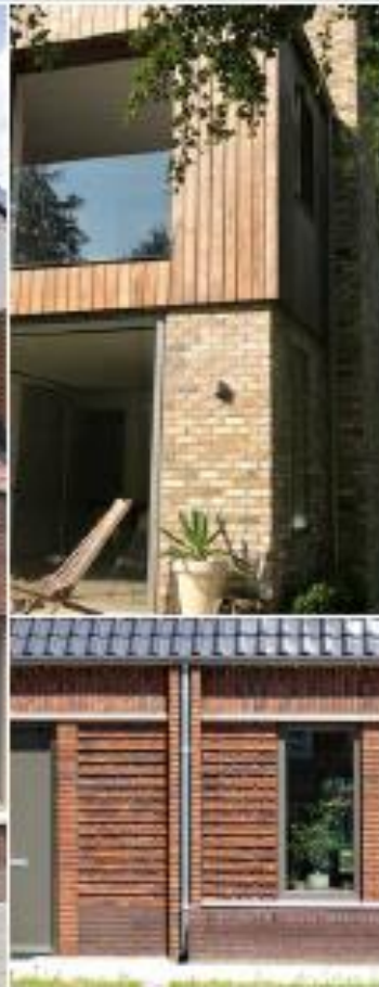
Zorgvuldige detaillering in metaalwerk en aansluiting regenwaterafvoer.
